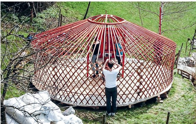
Holzmikado: Stab für Stab zwischen Krone und Gitter gespannt.
