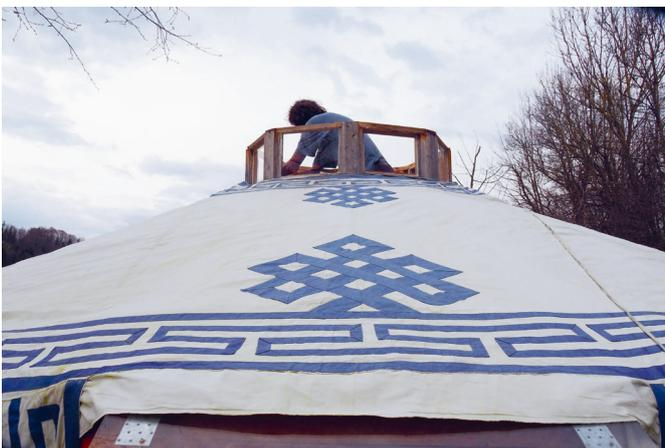
Muster: Die bedruckte Stoffschicht wird über dem Filz befestigt.
