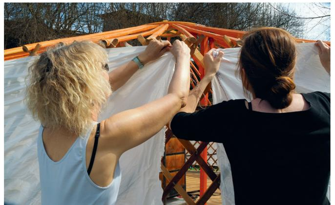
Stoffschicht: Zwischen Filz und Gitter wird ein Stoff gespannt.
