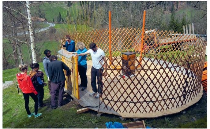
Scherengitter: Die Wand steht, die Türe wird nach Süden gerichtet.
